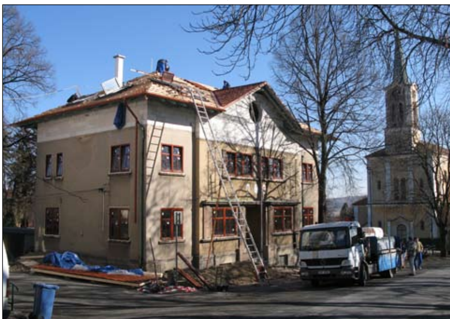
Potřebná rekonstrukce našeho obecního úřadu je v plném proudu.
