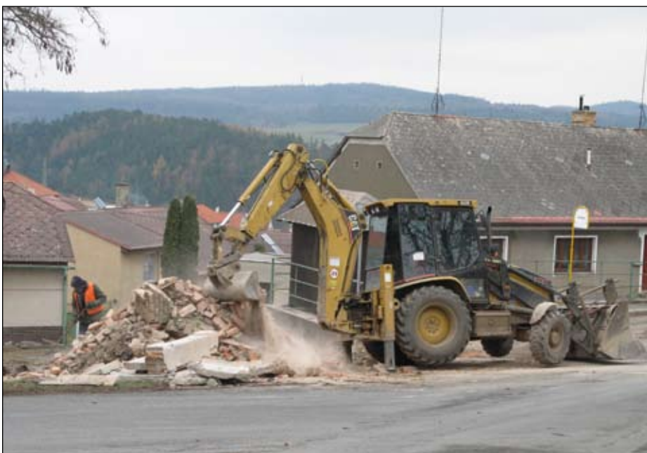
Stará trafostanice dosloužila.
