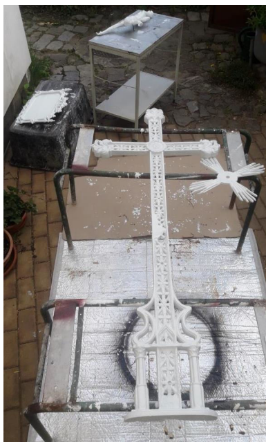
Nátěr základní barvou
