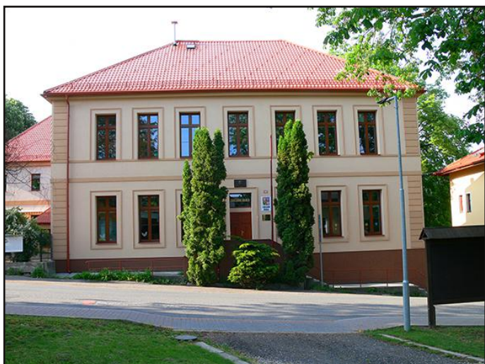
ZŠ - budova po rekonstrukci
