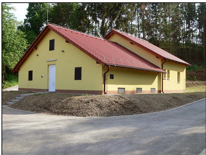
ČOV - budova s přístupovou cestou
