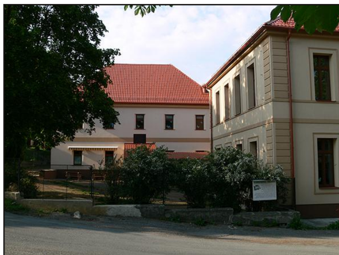
ZŠ stará škola - sanace a oprava střechy
