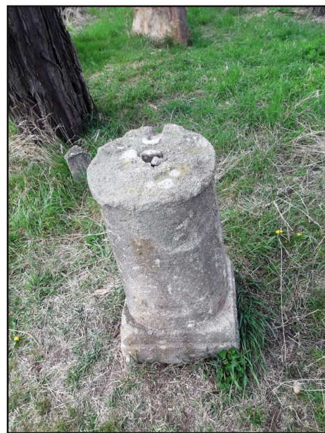
Původní stav soklu
